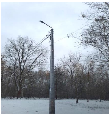
Fot. 59. Wymiana opraw ulicznych w miejscowości Żwirówka
