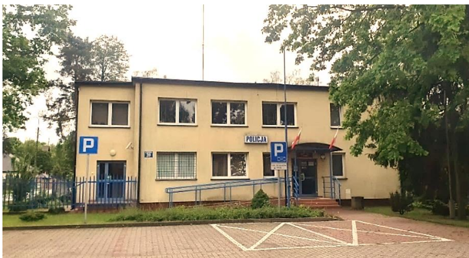
Fot. 135. Komisariat Policji przy ul. Piłsudskiego w Halinowie
