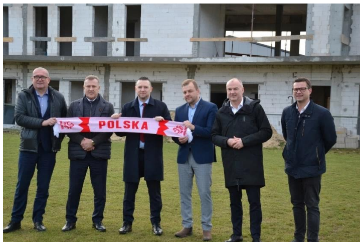
Fot. 81. Burmistrz Halinowa, Prezes KS Halinów oraz Przedstawiciele PZPN i MZPN na tle budowanego budynku - zaplecza sportowego w Długiej Kościelnej
