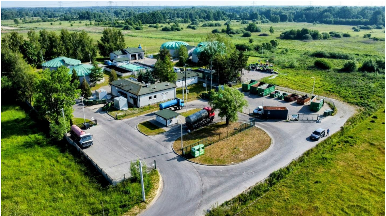
Fot. 43. Oczyszczalnia ścieków w Długiej Kościelnej z lotu ptaka
