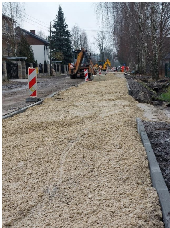
Fot. 53. Budowa ul. Powstania Styczniowego
