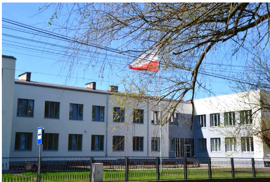
Fot. 91. Budynek Zespołu Szkolno-Przedszkolnego w Okuniewie po remoncie
