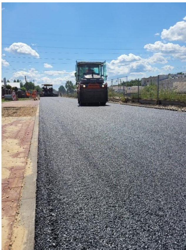
Fot. 177. Nowa nakładka asfaltowa ul. Chojniak w Długiej Kościelnej
