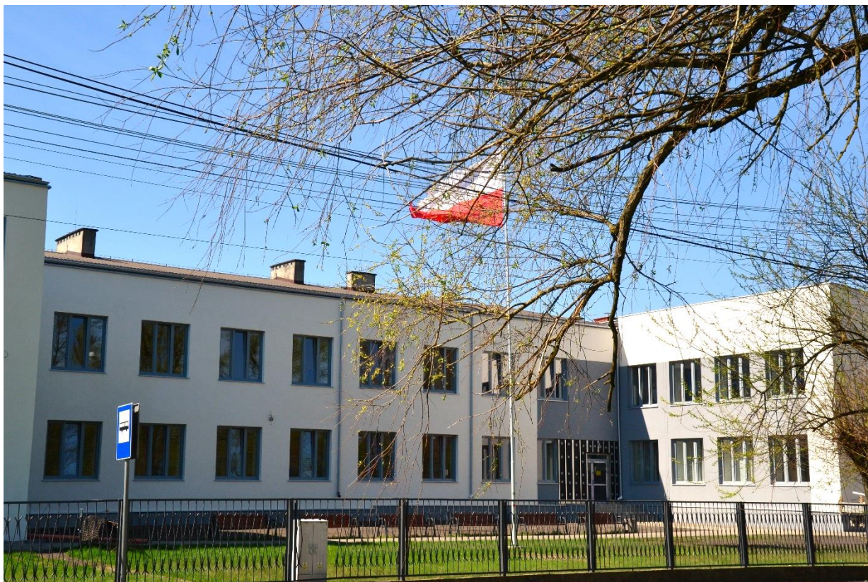
Fot. 52. Termomodernizacja Zespołu Szkolno-Przedszkolnego w Okuniewie
