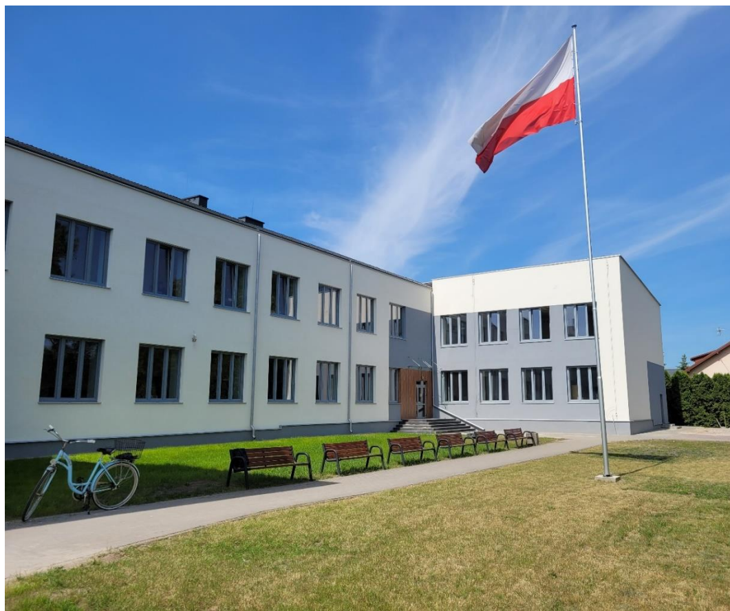
Fot. 161. Zespół Szkolno-Przedszkolny w Okuniewie po modernizacji elewacji
