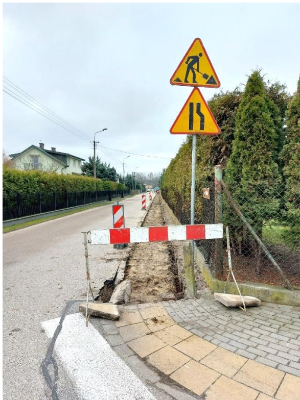
Fot. 78. Chodnik ul. Sadowa przed realizacją
