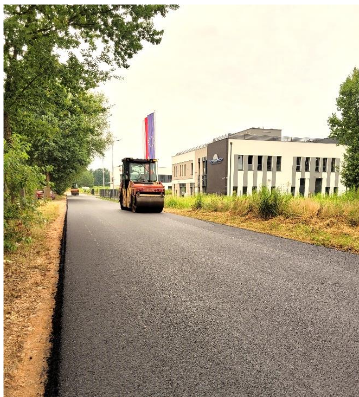
Fot. 189. Nowa nakładka asfaltowa ul. Konikowa Nowy Konik
